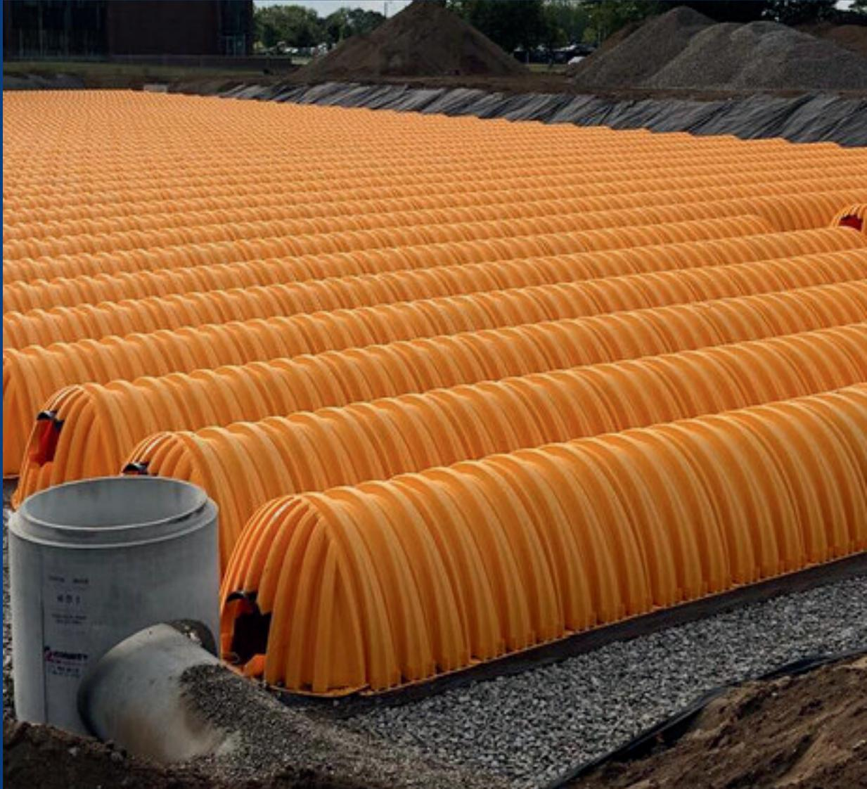
Solución ideal para la gestión de aguas pluviales en zonas urbanas, diseñado para controlar eficientemente el flujo extraordinario de agua durante tormentas y evitar inundaciones. Este sistema innovador no solo retiene el agua pluvial, sino que aísla los sedimentos y contaminantes de los primeros escurrimientos.
